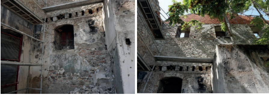
Fot. 14,15. Z05 mekânının batı cephesi
