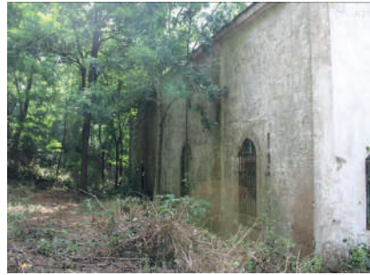
Foto. 14. Antyeri Köyü Kilise Camii kuzey cephesi
