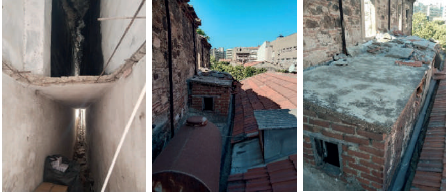
Fot. 6,7,8. Yapının kuzey cephesinden görünüm
