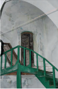
Foto. 19. Antyeri Köyü Kilise Camii kuzey çan kulesine çıkışı sağlayan bölüm
