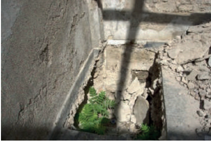
Fot. 37. Z01 mekânındaki gözlem çukuru
