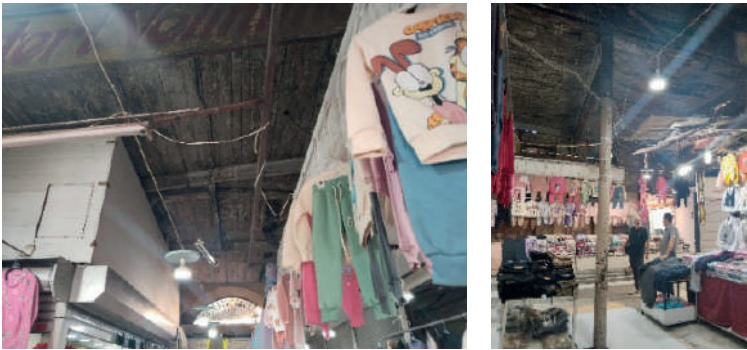
Fot. 41,42. Arap Hanı ahşap tavanı ve demir sütunlarının bir görünümü
