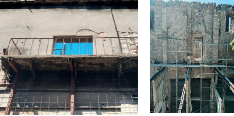
Fot. 31,32. Güney cephede yer alan balkondan görünüm
