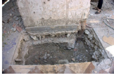
Fot. 38. Z04 mekânındaki gözlem çukuru
