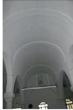
Foto. 24. Antyeri Köyü Kilise Camii tonozları
