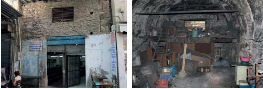
Fot. 27,28. Abdurrahman Hanı'nın cephesi ve içinden görünüm
