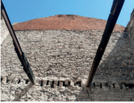
Fot. 11. Z01 mekânının doğu cephesi
