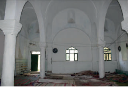
Foto. 17. Antyeri Köyü Kilise Camii doğu duvarı
