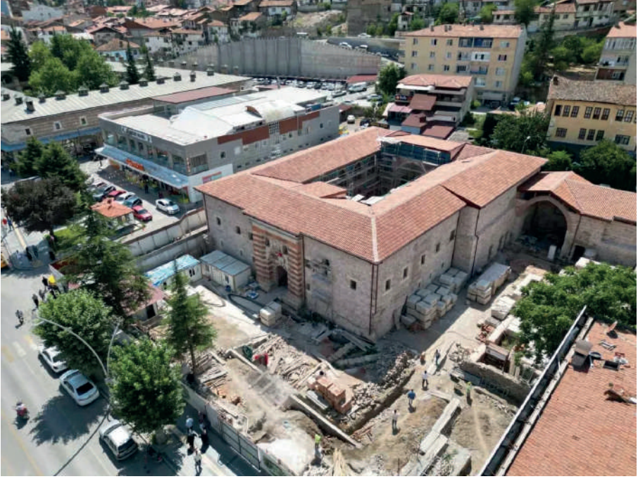
Resim 10- Gök Medrese Restorasyonundan Görünüm (2024)
