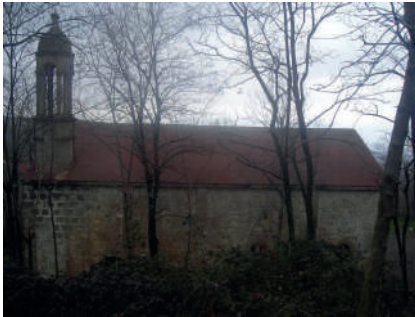
Foto. 13. Antyeri Köyü Kilise Camii kuzey cephesi
