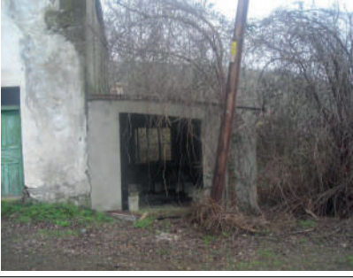
Foto. 15. Antyeri Köyü Kilise Camii kuzey cephesi
