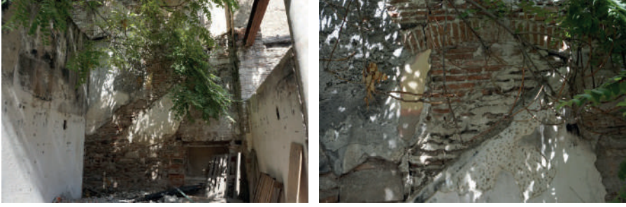
Fot. 29,30. Z05 mekânının kuzey cephesinden görünümü
