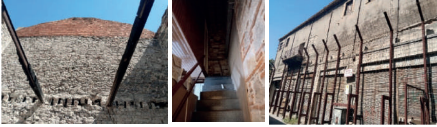
Fot. 43. Yapının kuzeydoğusundaki kiriş boşlukları
