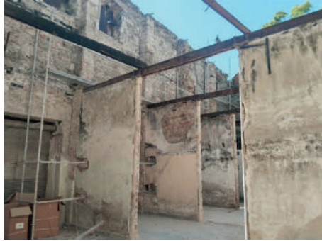
Fot. 13. Z01 mekânının batı cephesi
