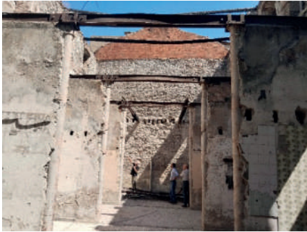
Fot. 9. Batı cepheden doğu yönüne bakış
