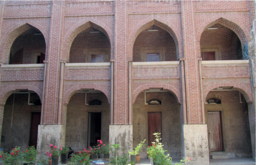
Foto. 54. Konya/ Sırçalı Medrese İki Katlı Kemerli Revaklar
