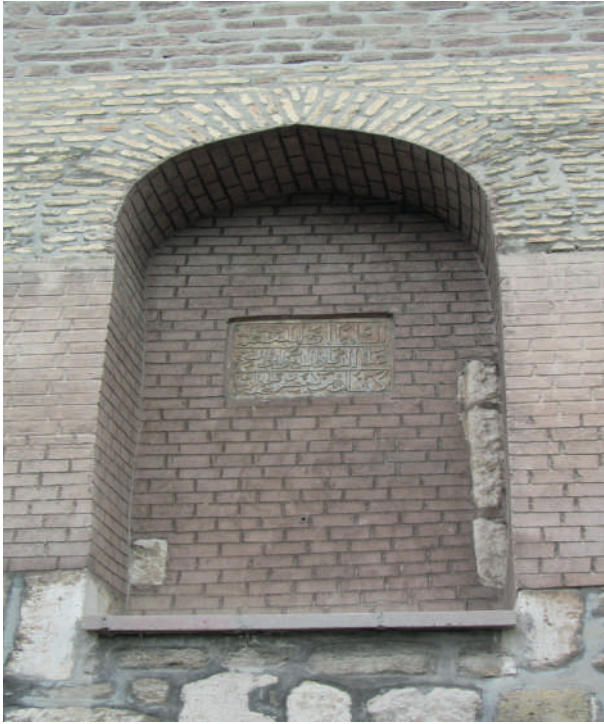
Foto. 17. Konya/Alâeddin Camii Batı Duvarındaki Örülü İlk Kapı İçindeki Kitabe
