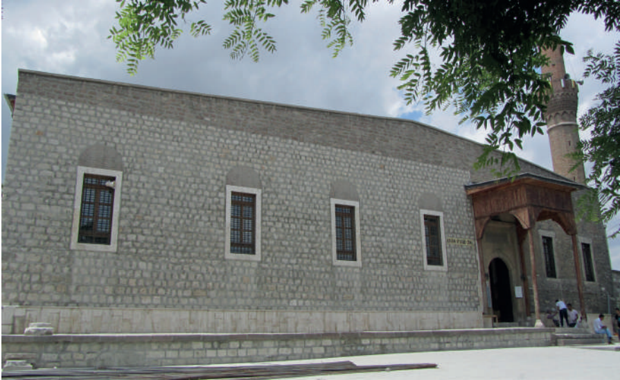
Foto. 11. Konya/Alâeddin Camii Genel Görünüş
