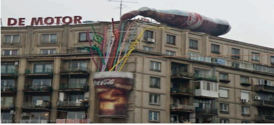
Resim 6. Dış Mekân Enstalasyonları Örneği
