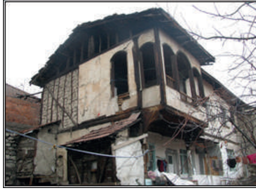
Şekil 3. Konutun genel görünüşü
