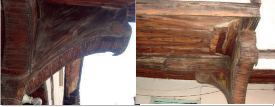
Şekil 20. Kıvrımlı ahşap payandada geometrik bezemeler
