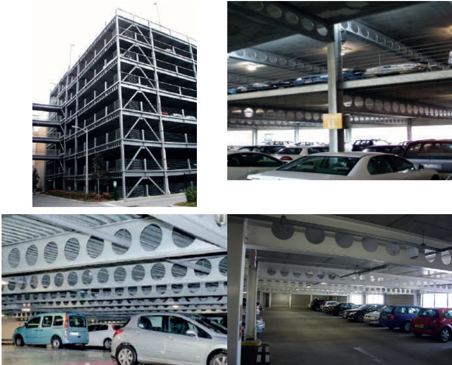
Şekil 5. Otopark yapılarında petek kirişler [9, 12-14]
