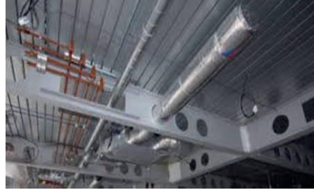
Şekil 7. Petek kirişlerde havalandırma ve iklimlendirme tesisatları
