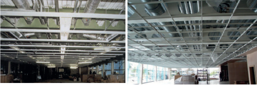
Şekil 9. Petek kirişlerde tavan yapısı [9]
