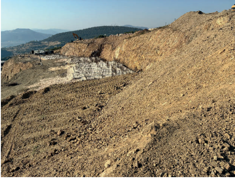
Şekil 1. Derin kazılar ve kot farkı
