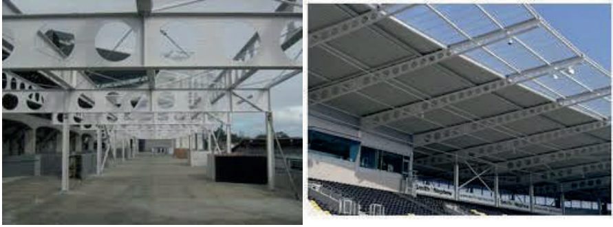
Şekil 11. Estetik petek kirişler ve konik çatı kiriş elemanları [9]
