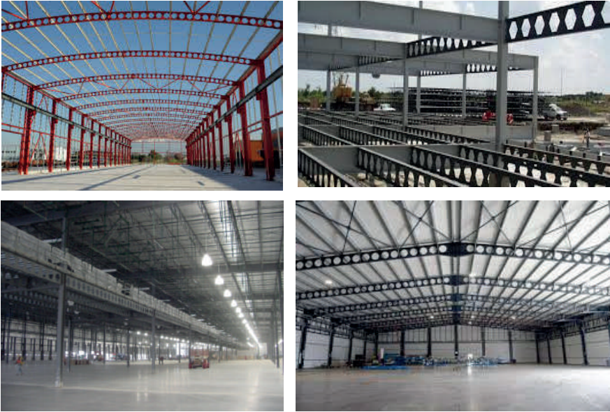
Şekil 6. Endüstri yapılarında petek kirişler
