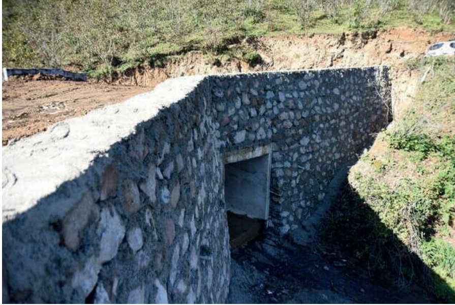
Şekil 2. Taş duvar destekli kutu menfez örneği [6].
