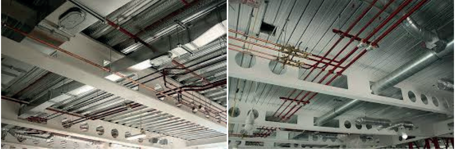
Şekil 8. Petek kirişlerde tesisat montajı
