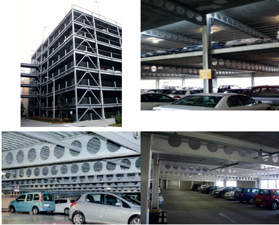
Şekil 5. Otopark yapılarında petek kirişler [9, 12-14]
