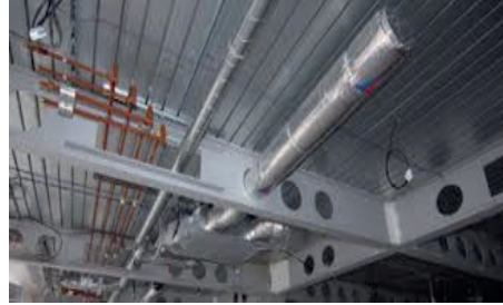
Şekil 7. Petek kirişlerde havalandırma ve iklimlendirme tesisatları
