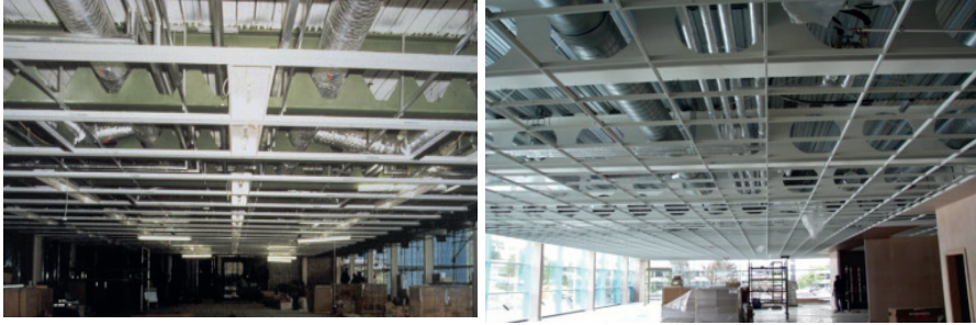
Şekil 9. Petek kirişlerde tavan yapısı [9]
