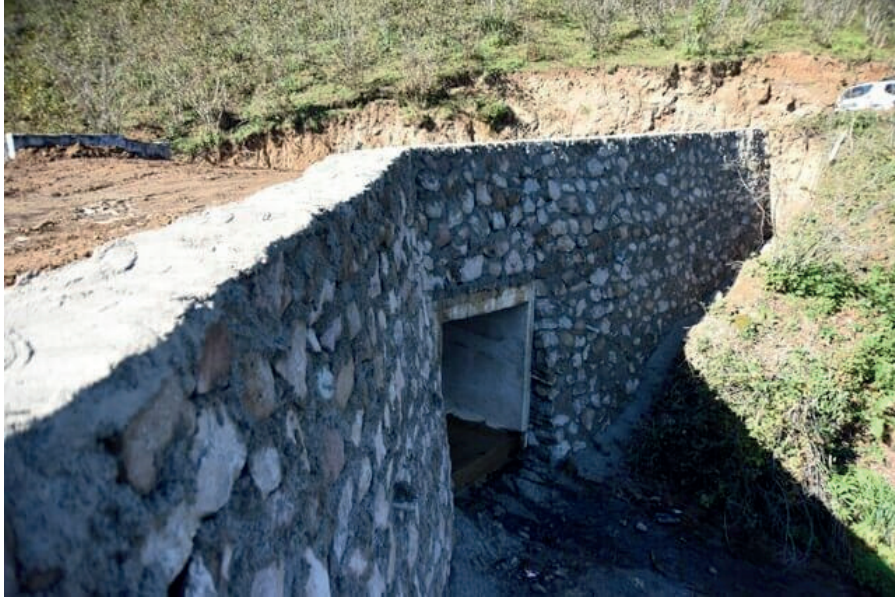
Şekil 2. Taş duvar destekli kutu menfez örneği [6].
